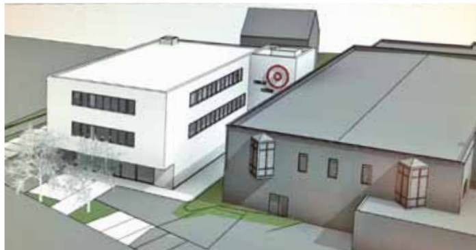
Mit einem Verbindungsterminal zum Gebäude, in dem sich der Edeka-Markt und ein Fitnesscenter befinden, ist der gesamte Komplex barrierefrei.
