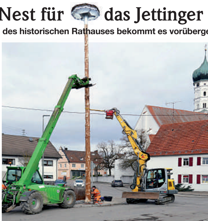
Aus Sorge um das Storchenpaar und die Aufzucht der Jungen hat der Markt Jettingen-Scheppach für dieses während der Dachsanierung des historischen Jettinger Rathauses ein vorübergehendes Zuhause geschaffen. Mitarbeiter des Bauhofs haben auf dem Marktplatz einen zwölf Meter hohen Masten mit dem Nest aufgestellt. (Bild: Christoph Böhm)
